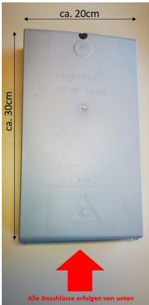
Abbildung 10: Hausanschlussbox
