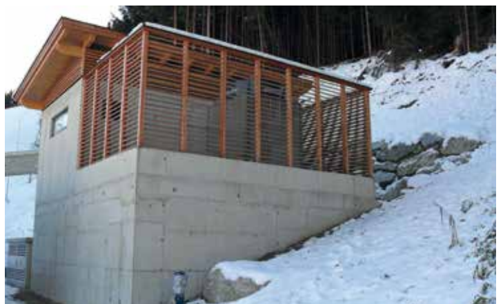
Das neu errichtete Pumphaus
